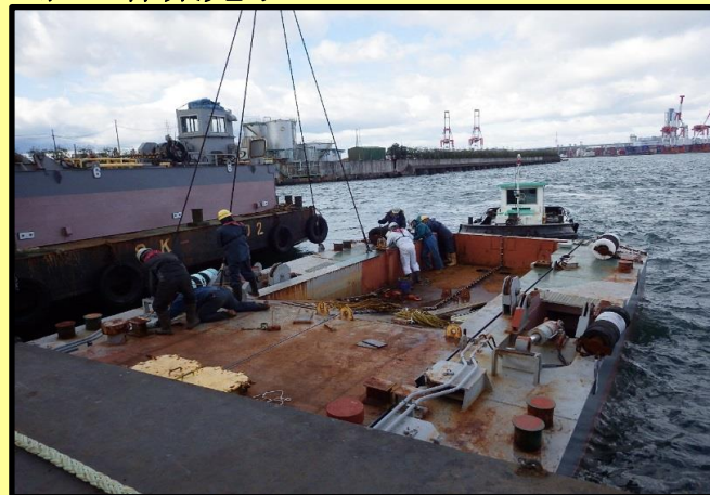
組立作業完了
