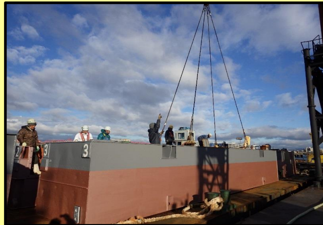
ユニット吊込み
