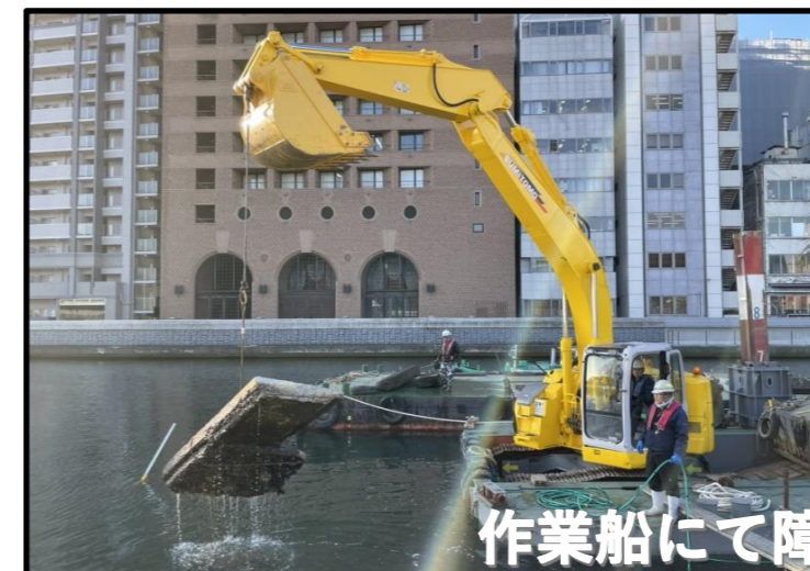
作業船にて障害物撤去作業
